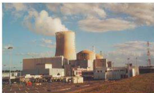
Energía nuclear controlada en una central nuclear
